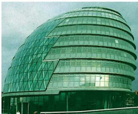
Здание Мэрии Лондона (архитектор Сэр Норман Фостер)
