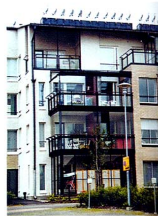
Застекленные лоджии обеспечивают предварительный подогрев приточного воздуха в холодный период
