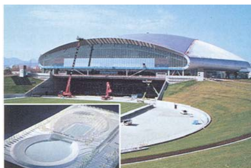
Крытая арена частично заглублена в грунт
