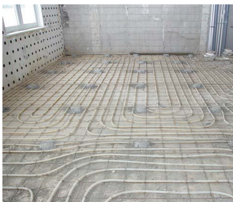
Укладка труб напольного отопления. Обращает на себя внимание уменьшение шага укладки труб в зоне окон
