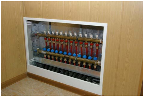
Подключение контура напольного отопления в здании администрации поселка Птичное
