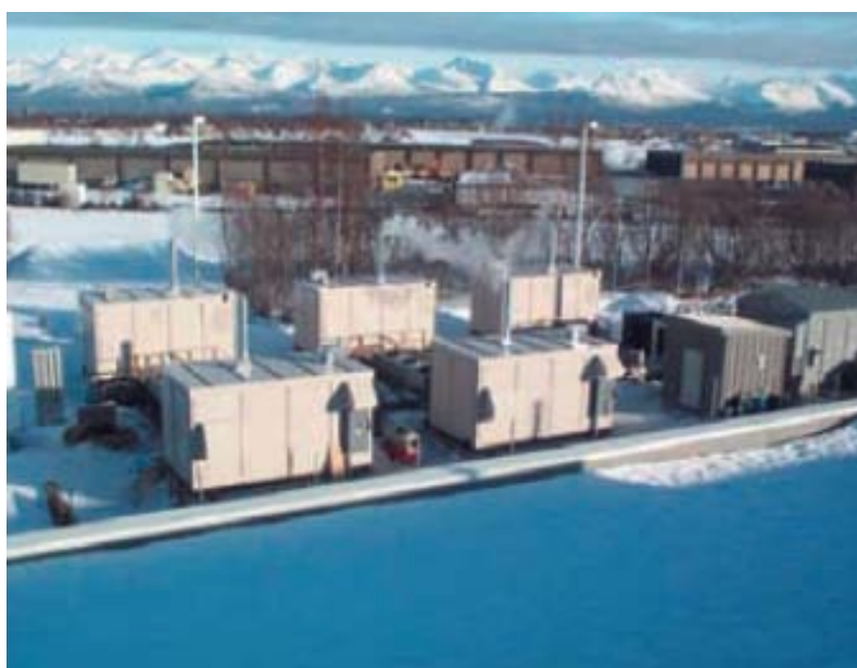
Система теплоэнергоснабжения почтовой службы на Аляске на основе пяти топливных элементов
