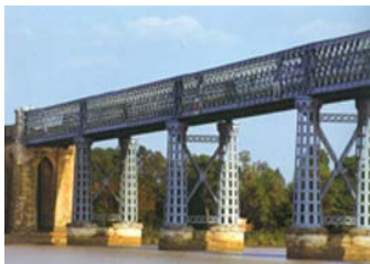
Г. Эйфель. Мост. Либурн. Франция. 1880
